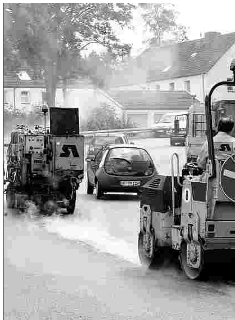
Auf den Serpentinaen qualmt es: Auf einer Länge von 840 Metern wird auf der B 258 vor Monschau die Griffigkeit der Fahrbahn verbessert. Foto: P. Stollenwerk
