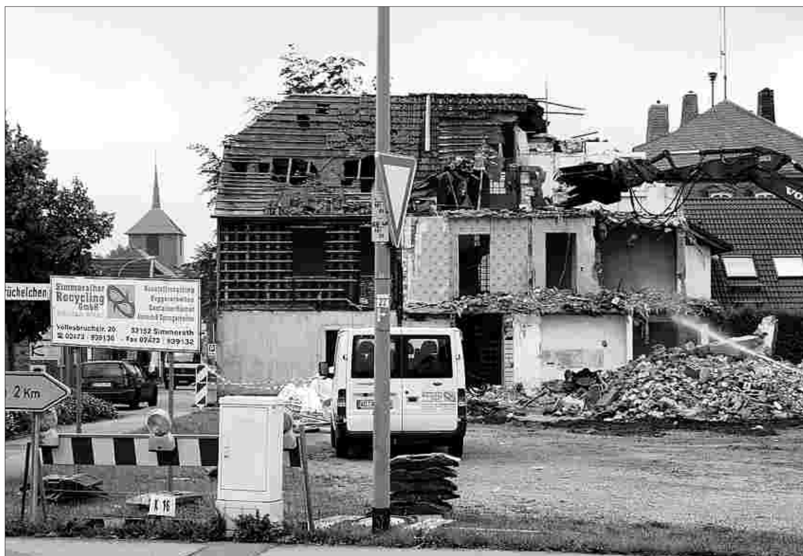
Mehr Parkplätze im Ortskern: Der Abriss eines Wohnhauses an der Trierer Straße in Imgenbroich soll auch künftig den Verkehr auf der Bundesstraße 258 entzerren. Foto: P. Stollenwerk
