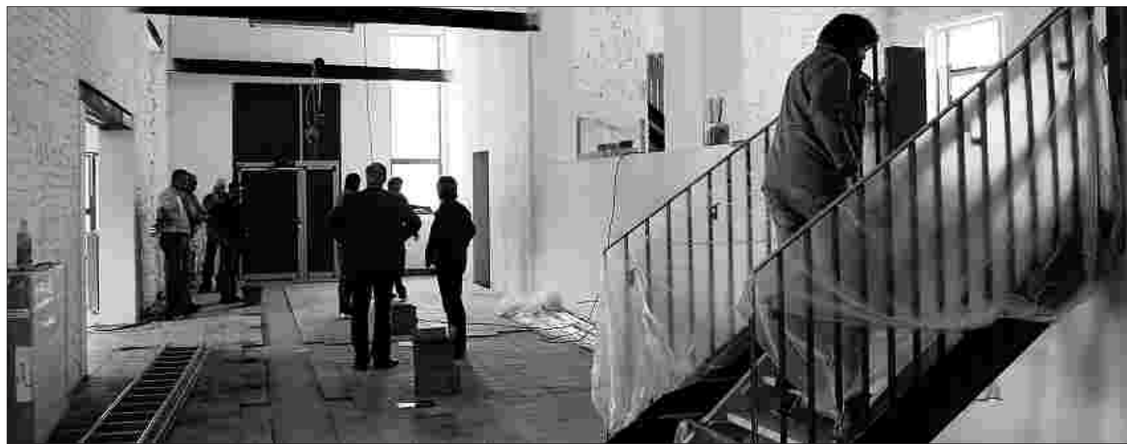
Noch ist das Nationalparktor in Höfen eine Baustelle. Im August sollen sich hier die Gäste auf den Nationalpark Eifel einstimmen.
