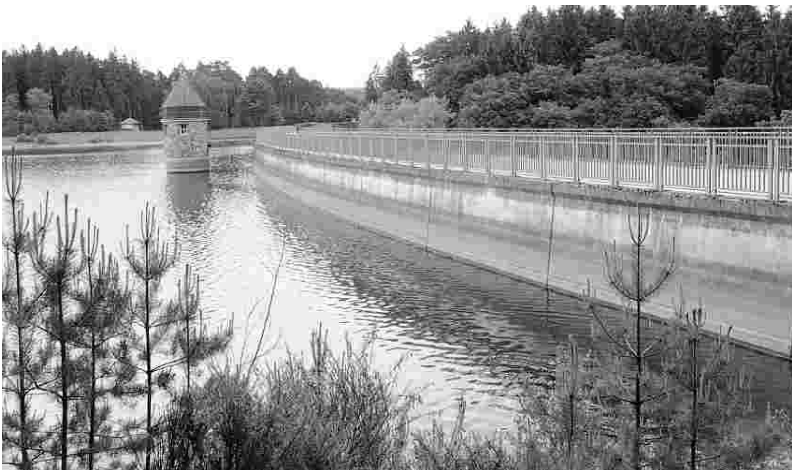
Schön anzusehen, aber für Wanderer in der Regel weit weg. Der Rundweg um die Dreilägerbachtalsperre in Roetgen ist nach wie vor gesperrt. Jetzt soll ein neuer Vorstoß aus der Ortspolitik gestartet werden. Foto: P. Stollenwerk
