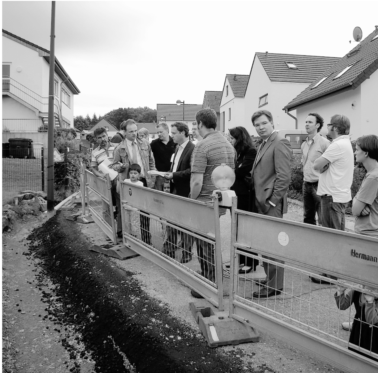
Vor Ort informierte sich Bauausschussvorsitzender Michael Seidel bei den aufgebrachten Anwohnern über den Stand des Straßenausbaus im Rottter Neubaugebiet „Im Gehaaks“. Foto: Helga Giesen
