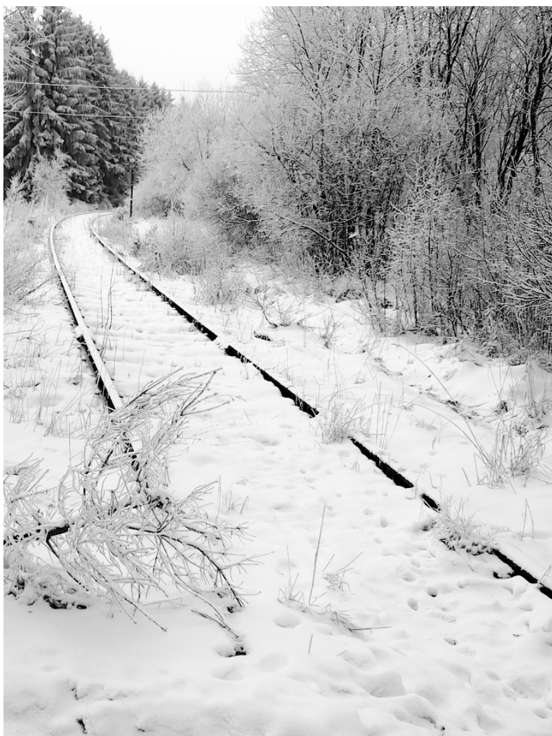
Noch sind die Schienen der alten Vennbahn verschneit (wie hier in Konzen), doch bald werden sie abgebaut, die Trasse wird freigeschnitten, das Astwerk wird entsorgt: Schon im Juli sollen die Arbeiten aus Ausbau des Radweges auf der Vennbahntrasse beginnen. Foto: dm
