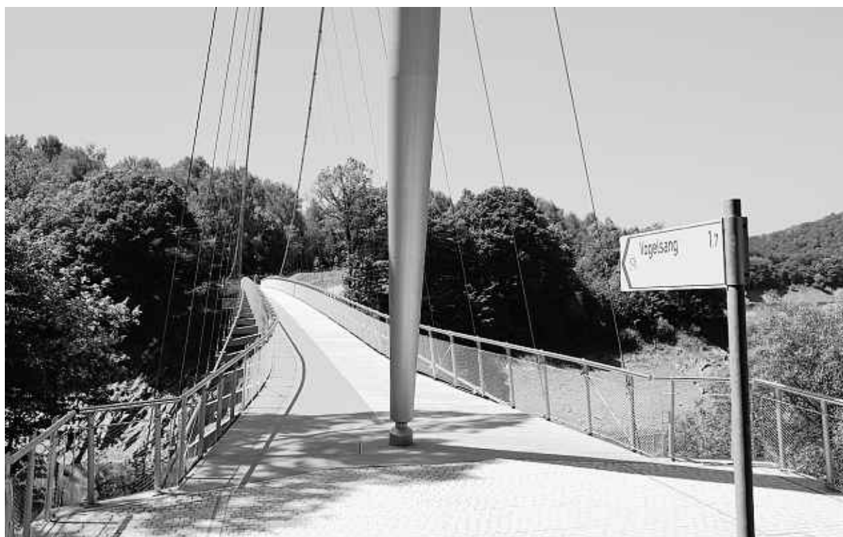
Die Brücke über den Urfsee, die die Kreisstraße 7 mit Vogelsang verbindet, wurde vom Nidegger Ingenieur Lorenz Cornelissen und der Architektin Jutta Rodeheger entworfen. Mit dem Entwurf überzeugten sie die Jury des Deutschen Stahlbau-Verbands. Foto: Hilgers
