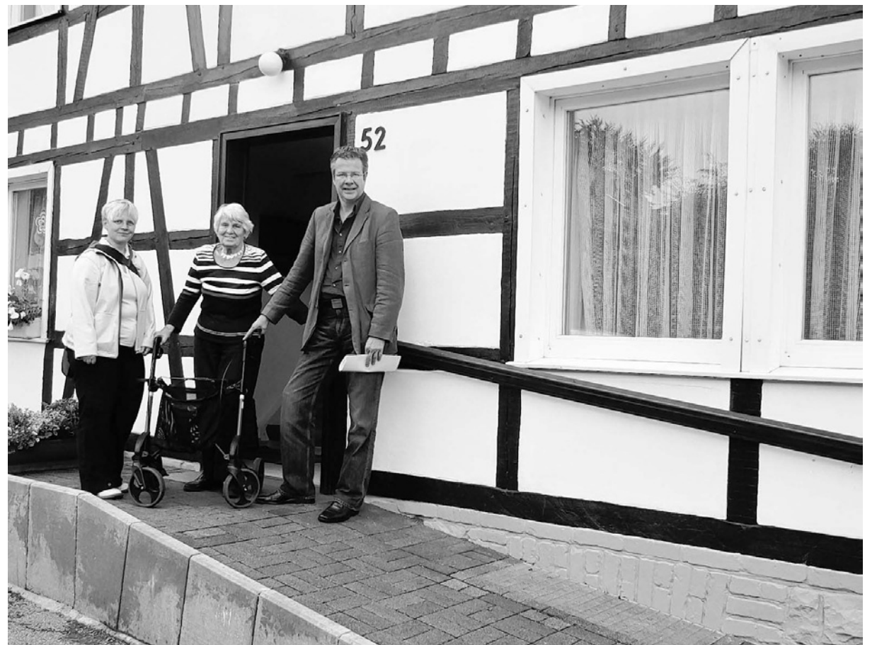
Stephan Löhmann und Yvonne Berg vom Pflegestützpunkt der Städteregion freuen sich mit Martha Victor über den gelungenen Umbau. Dank der neuen Rampe kann sie das Haus wieder ohne fremde Hilfe verlassen.
