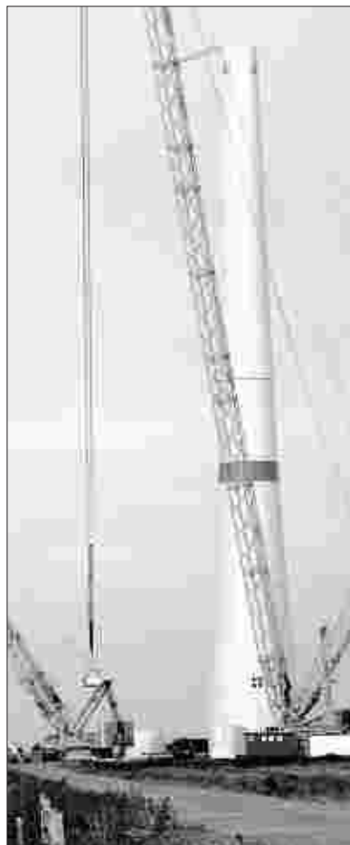
Im August 2007 wurde in Emden die erste Enercon-Windanlage E126 errichtet (Bild), mittlerweile drehen sich drei der Mega-Windräder an der Nordseeküste – und vielleicht bald eines in Rollesbroich?
