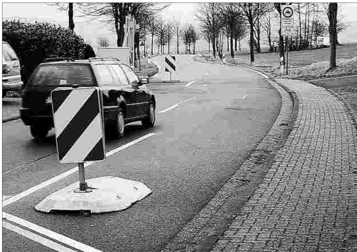
Weitere Verkehrsberuhigungsmaßnahmen sind auf der L 128 in Steckenborn vorgesehen. Eine mobile Fahrbahnverengung, wie bereits auf der Ortsdurchfahrt Richtung Woffelsbach (Bild) installiert, soll auch im Bereich Langgasse erfolgen. Foto: P. Stollenwerk
