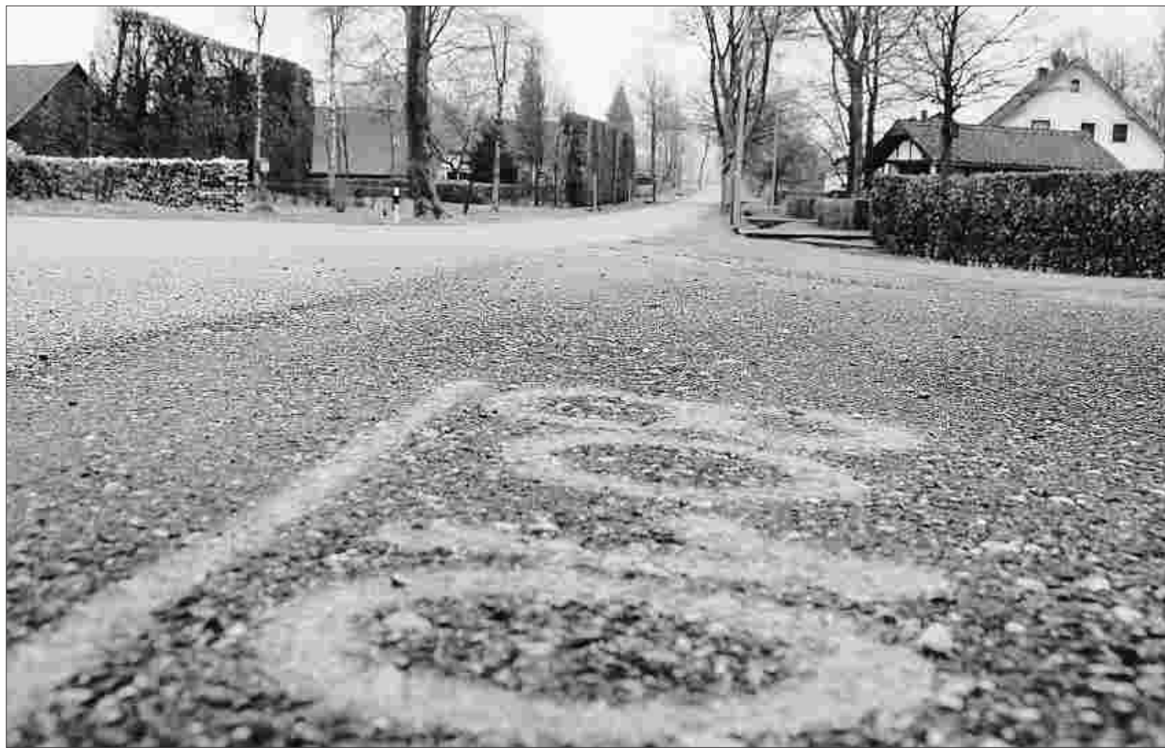
Idyllisch gelegen, schwer zu erschließen: Die Siedlung Ruitzhof, die zu Kalterherberg gehört, soll nun Kanal bekommen, rosa Zahlen auf der Straße künden von der Vorarbeit der Planer. Das Verlegen der Abwasserleitung in der weit gestreuten Wohnbebauung mit 18 Häusern ist mit hohem Aufwand verbunden, zumal die Straße große Höhenunterschiede aufweist. Foto: Heiner Schepp
